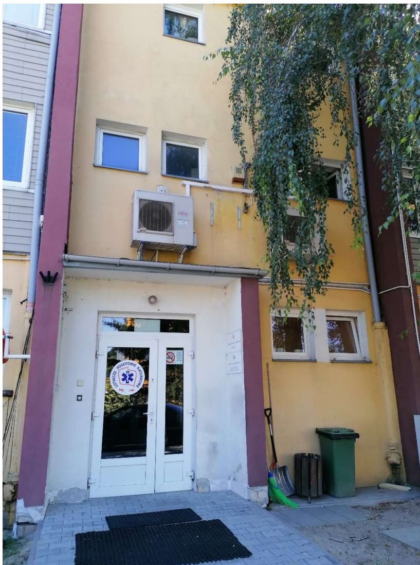
Fot. 6 Wejście do budynku s.d.
