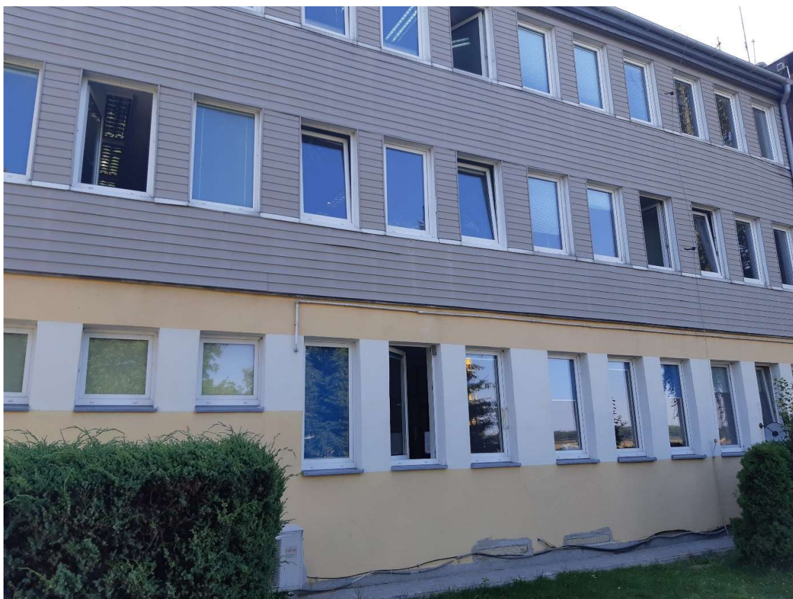
Fot. 3 Elewacja północna widok ogólny
