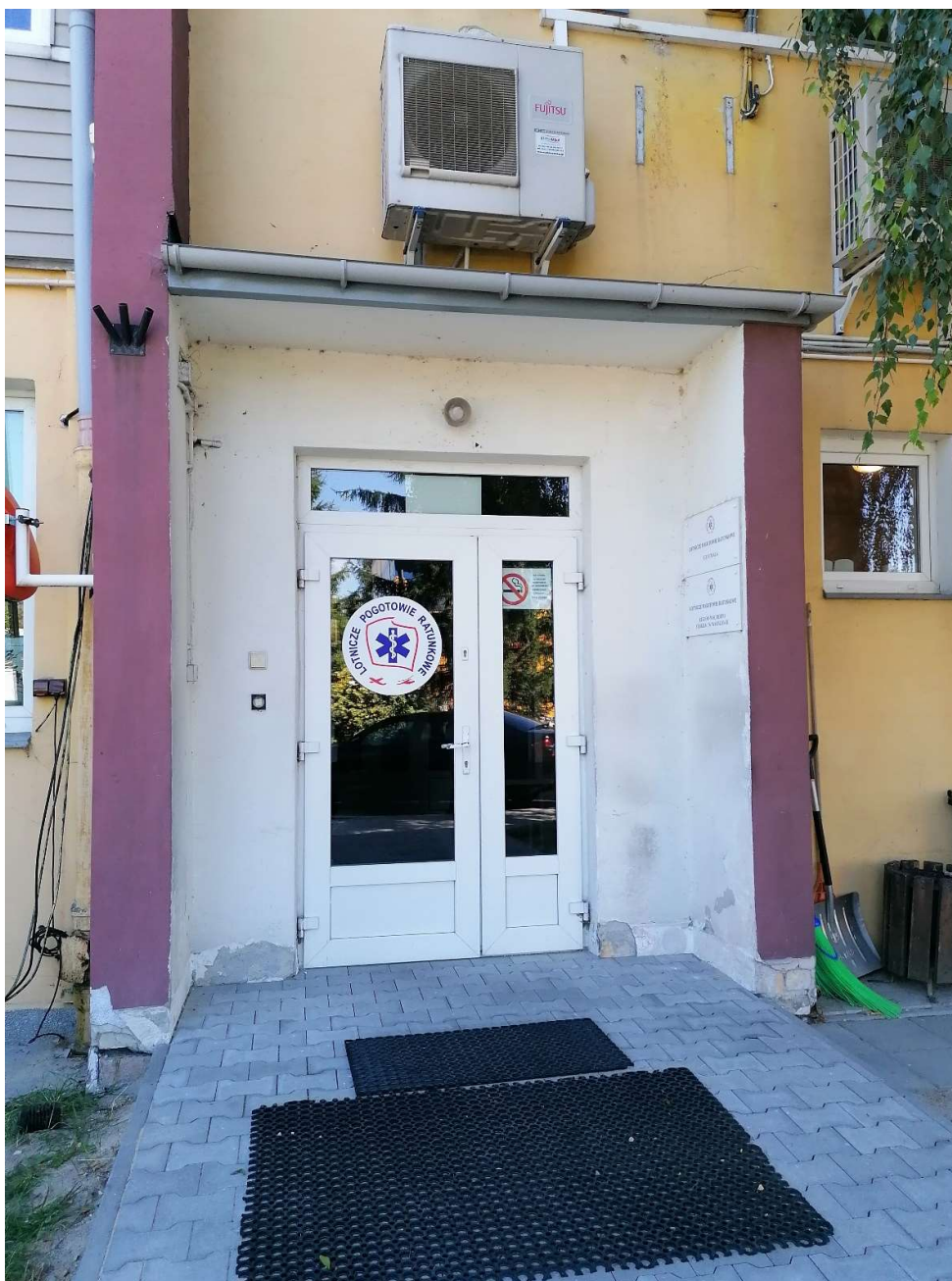
Fot. 5 Wejście do budynku
