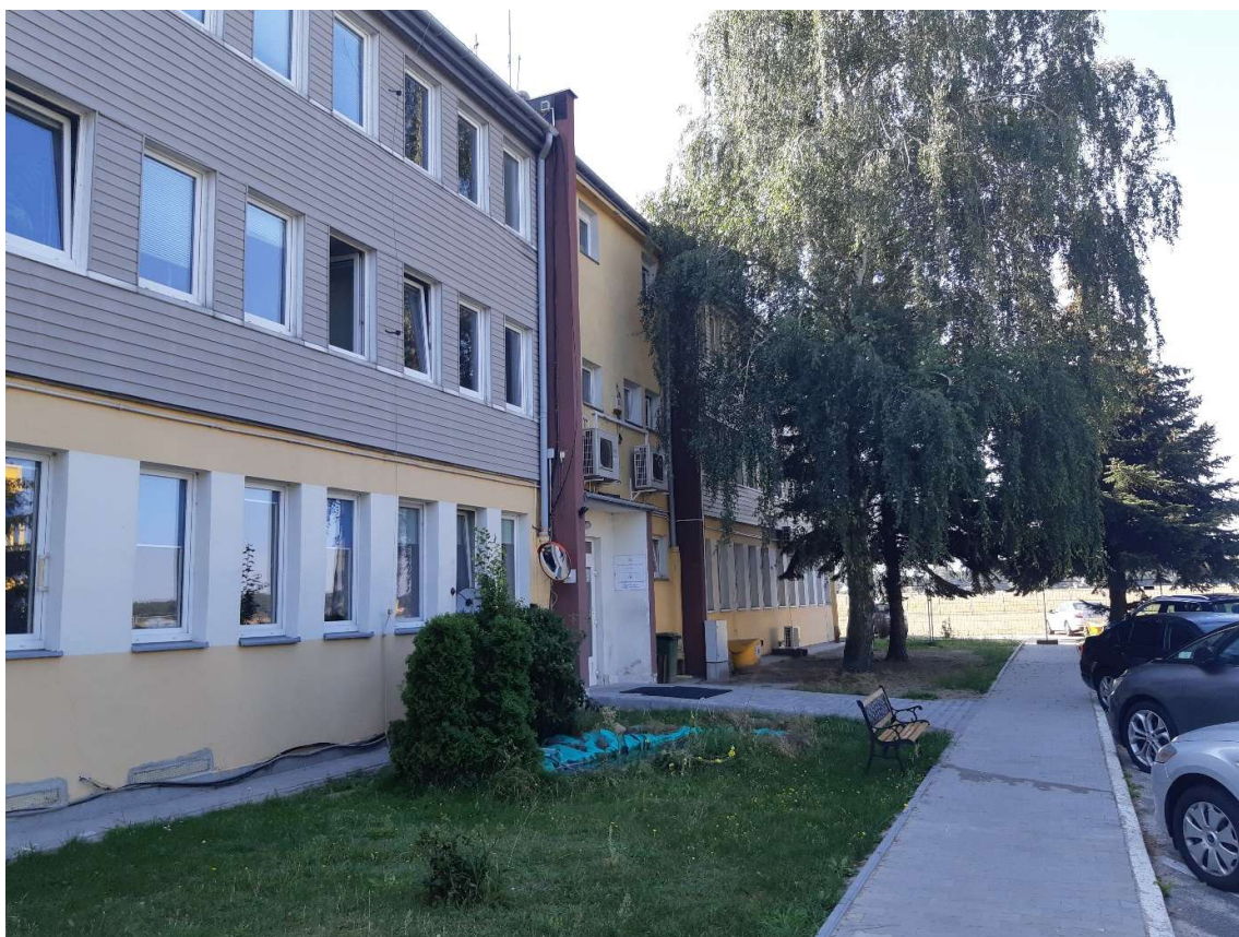
Fot. 4 Elewacja północna widok ogólny c.d.
