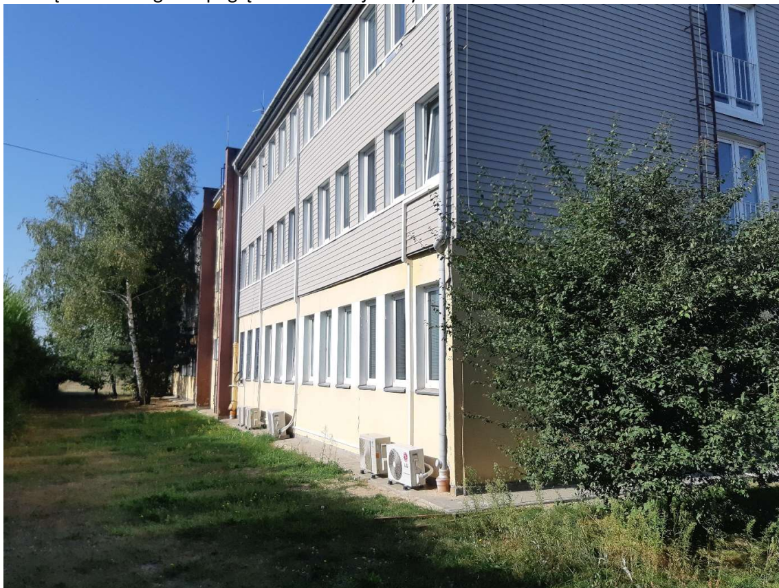
Fot. 1 – Elewacja południowa widok ogólny
