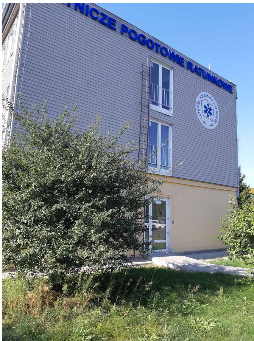
Fot. 2 Elewacja wschodnia widok ogólny
