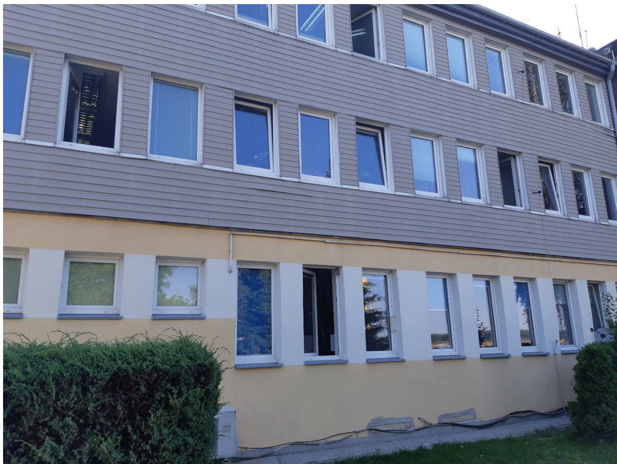
Fot. 3 Elewacja północna widok ogólny
