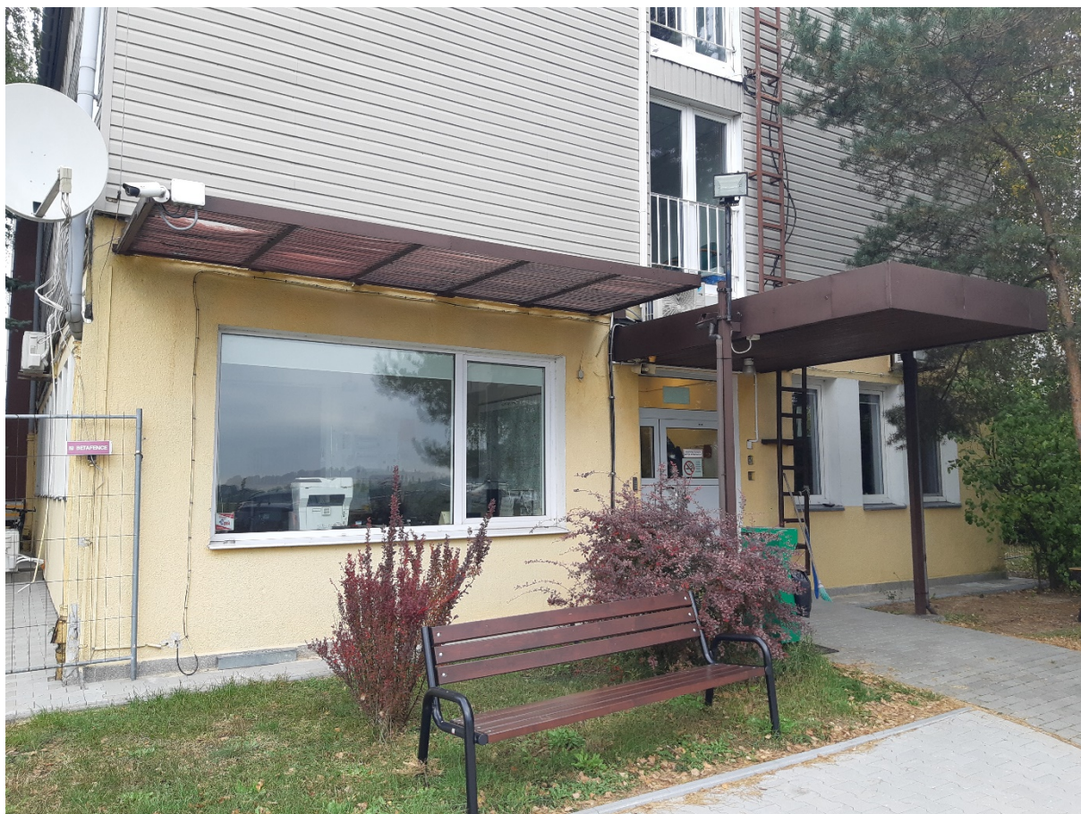
Fot. 12 Elewacja zachodnia
