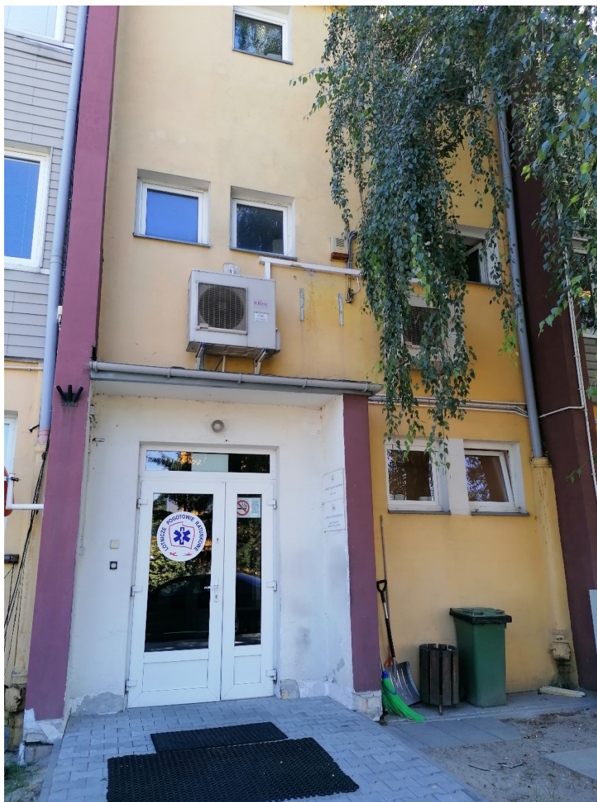
Fot. 6 Wejście do budynku c.d.
