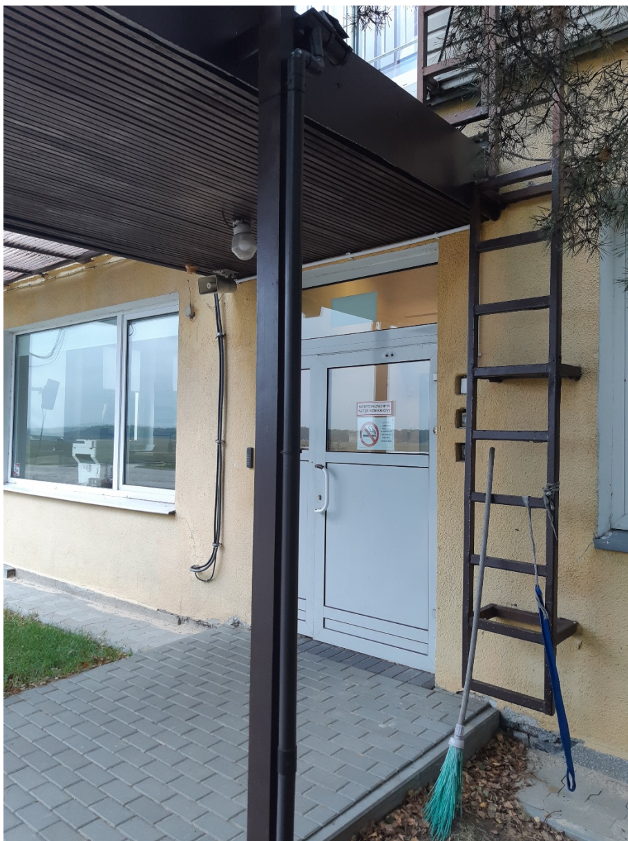
Fot. 13 Elewacja zachodnia - wejście
