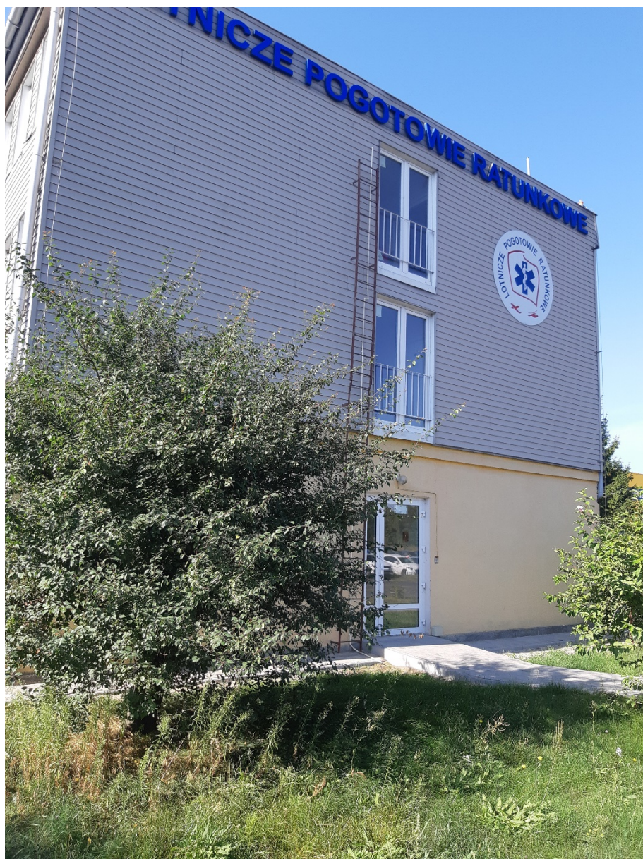
Fot. 2 Elewacja wschodnia widok ogólny
