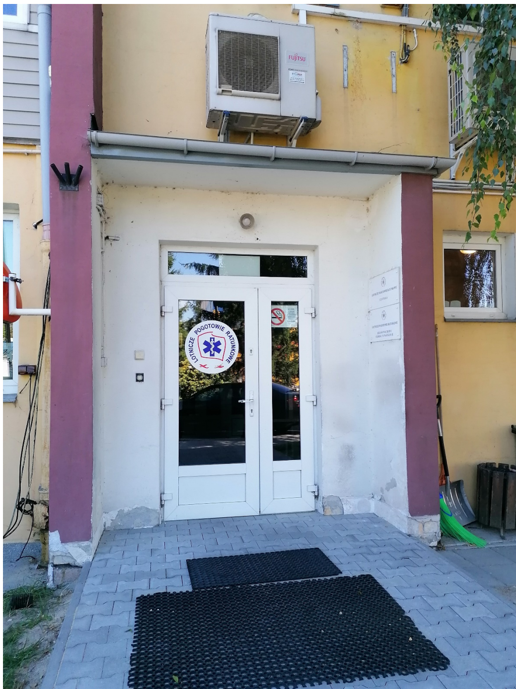
Fot. 5 Wejście do budynku
