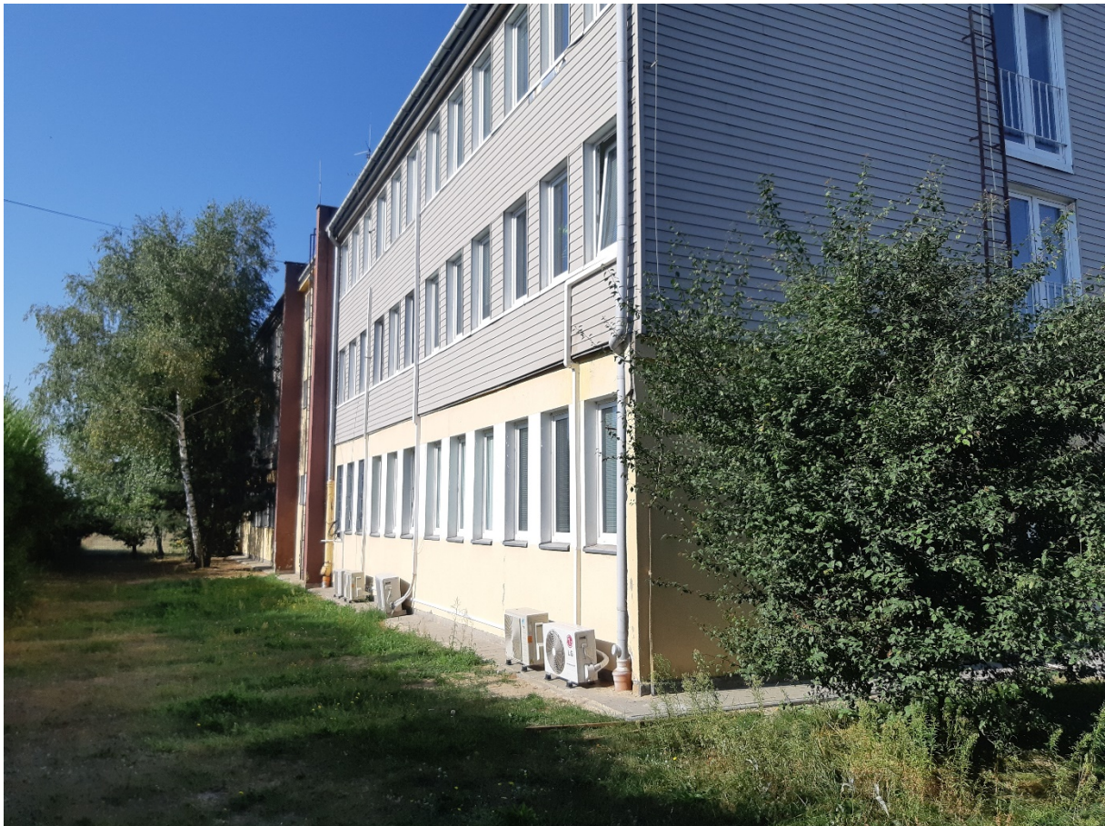
Fot. 1 – Elewacja południowa widok ogólny
