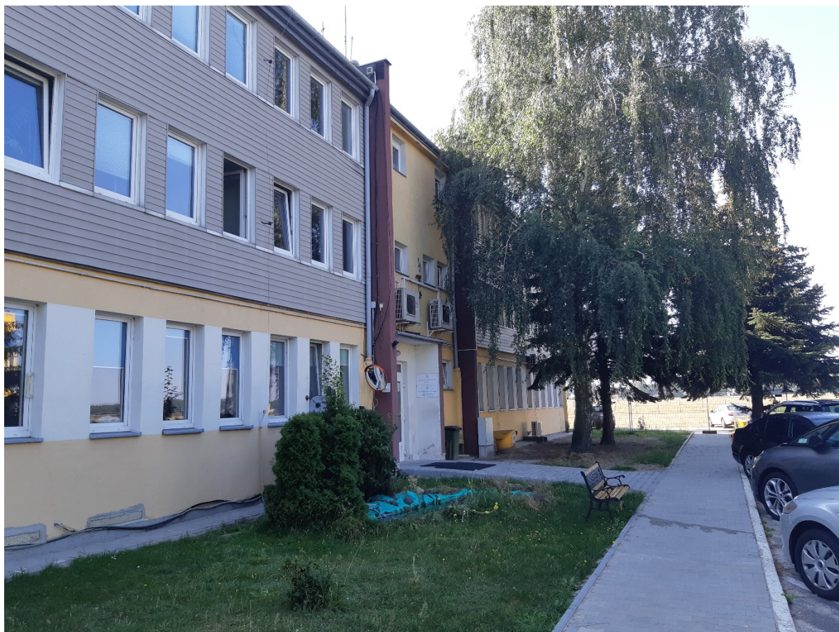
Fot. 4 Elewacja północna widok ogólny c.d.
