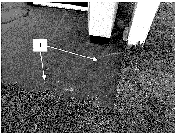
Fot. 9. Widok na wierzch płyty stropowej
