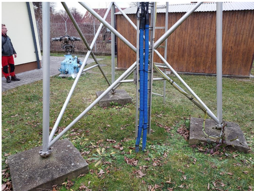
Widok rur przepustowych i uziemień
