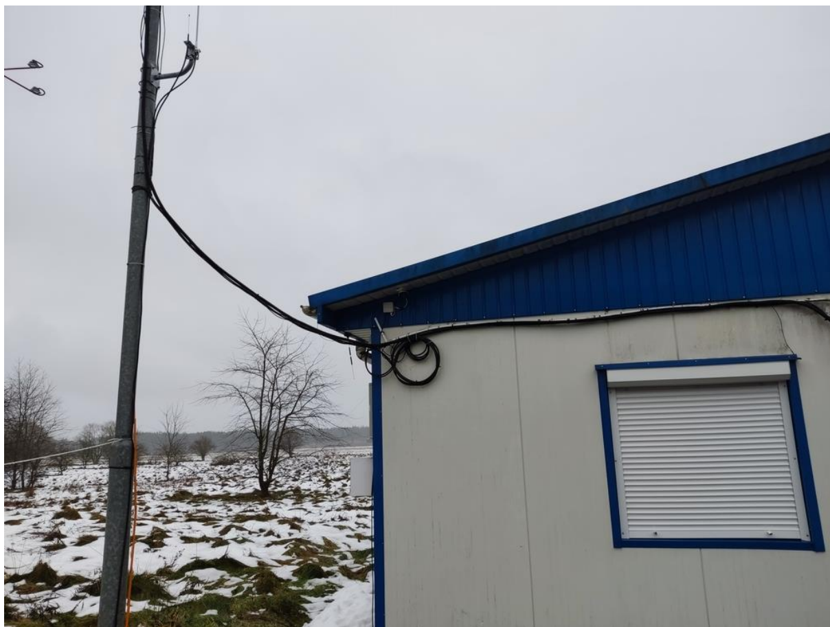
Lokalizacja planowanego przepustu do pomieszczenia serwerowni obok otworu wentylacyjnego w ścianie zewnętrznej z płyty warstwowej
