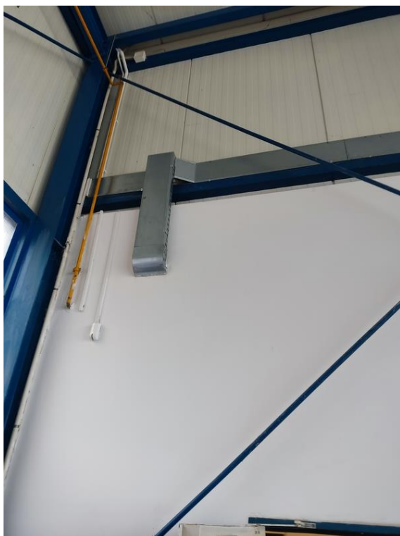
Przepust kablowy do serwerowni (hangar lotniczy, serwerownia)
