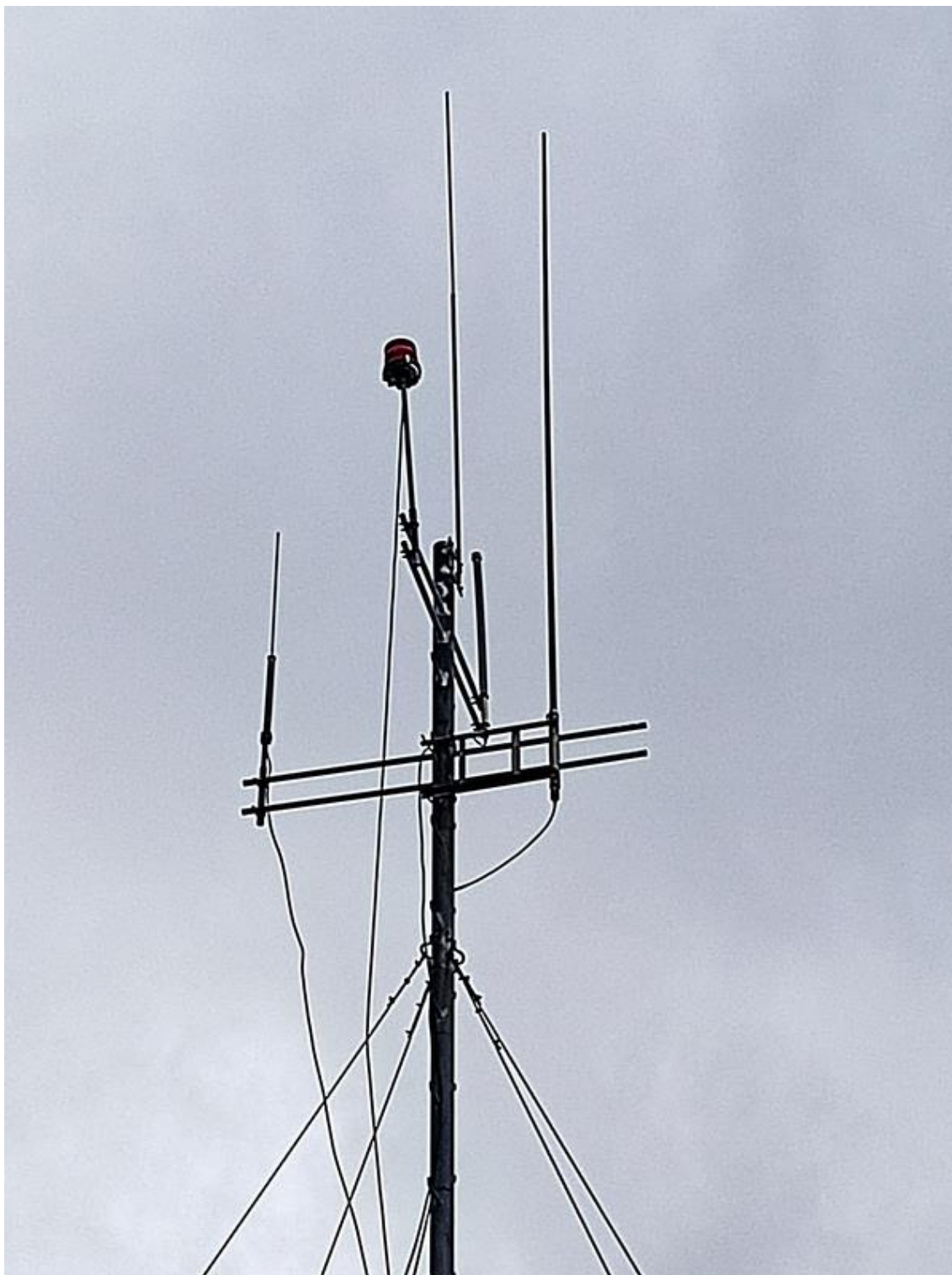
Widok anten dookólnych zainstalowanych na maszcie
