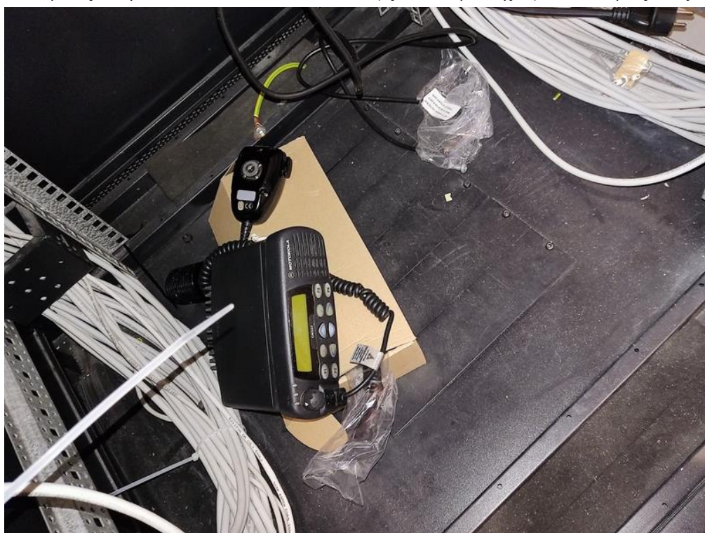
Niepodłączony radiotelefon Motorola GM360 (łączość operacyjna) w szafie sprzętowej
