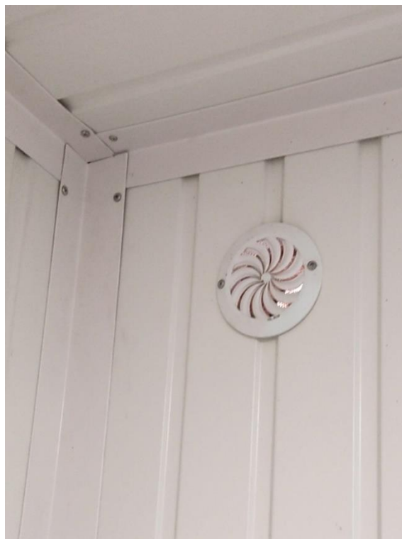
Lokalizacja planowanego przepustu do pomieszczenia serwerowni obok otworu wentylacyjnego w ścianie zewnętrznej z płyty warstwowej
