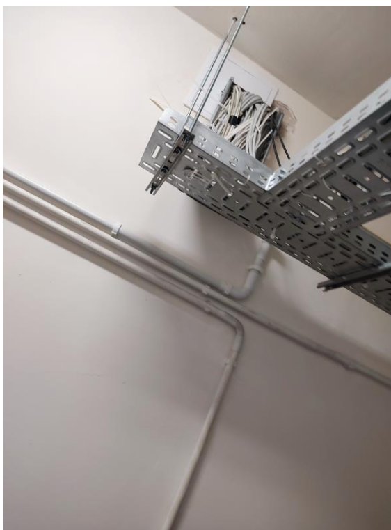
Przepust kablowy do serwerowni (hangar lotniczy, serwerownia)
