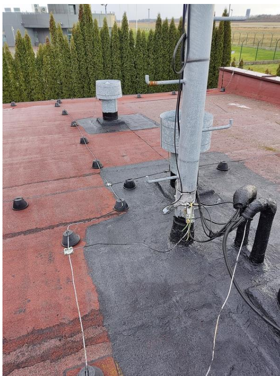
Przepust rurowy do budynku
